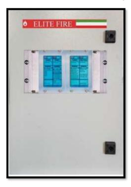
Elite Fire è stata progettata per essere una piccola centrale ma con tutte le potenzialità e caratteristiche della centrale madre EXFIRE360, la differenza tra le due e di tipo strutturale tutta la parte di visualizzazione comprensiva di 2 CPU, 1 Display e 1 BusCpu, sono state compattate in un'unica scheda mantenendo la ridondanza delle CPU con estrazione a caldo e lo stesso Firmware delle precedenti con processore certificato SIL 3.
